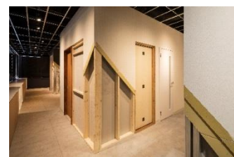
現物・施工性の確認
